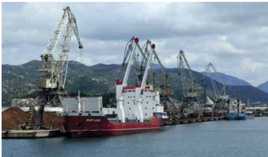
Teretni dio Luke Ploče
